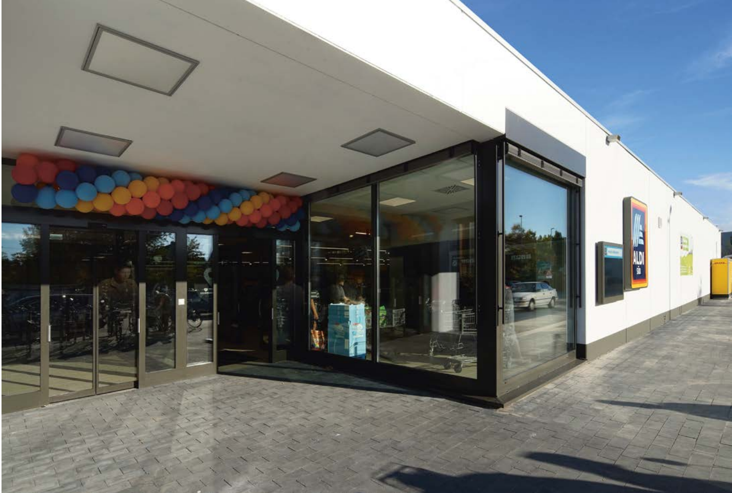
Die im Rahmen des dena-Modellvorhabens „Energieeffizient Handeln“ sanierte Filiale von ALDI SÜD in Frankfurt-Schwanheim verbraucht 45 Prozent weniger Energie als vor der Sanierung.
