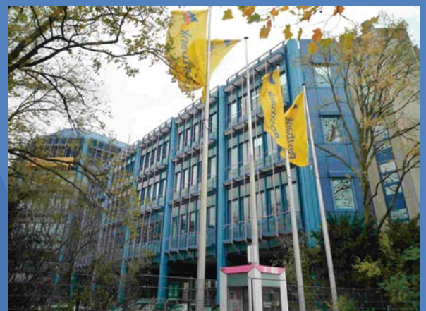
Moderne Fenster mit Isolierverglasung und eine automatische Verschattungsanlage senken den Energiebedarf und sorgen für ein angenehmeres Raumklima.
